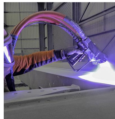
Fig. 7 – Zincagem por arco elétrico.
