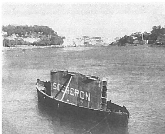
Fig. 7 — Montagem de um caixão do 3.º troço — Transporte
